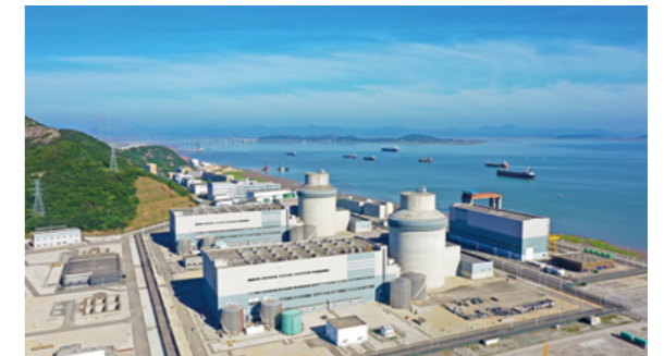
三门核电一期工程
