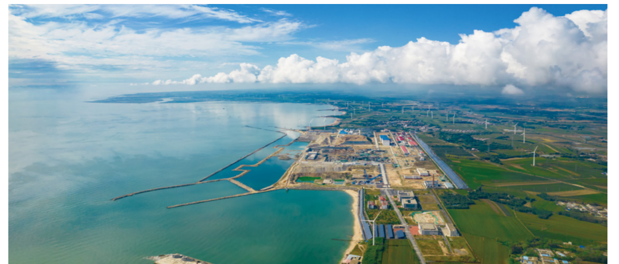
徐大堡核电厂区全景图
