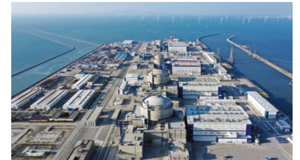
福清核电厂区全景
